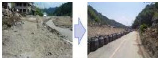
道路啓開の実施
