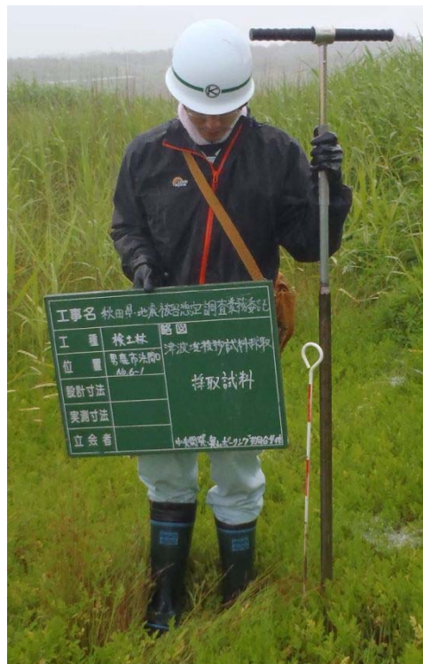
写真-17.4.1.1 検土杖による掘削風景
